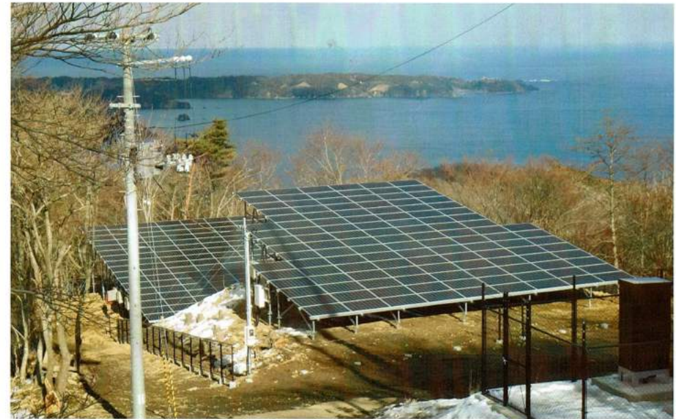
大六天発電所(NPO法人 おながわ・市民共同発電所) 開設日:平成30年2月6日 社鹿郡女川町高白浜字向山 全量買取制度利用・280w パネル264枚 73.92kwシステム 販売施工 株式会社プロジェクトウサミ
