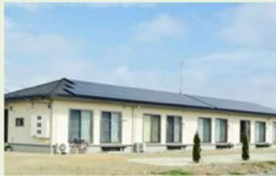
集合住宅屋根ソーラー
